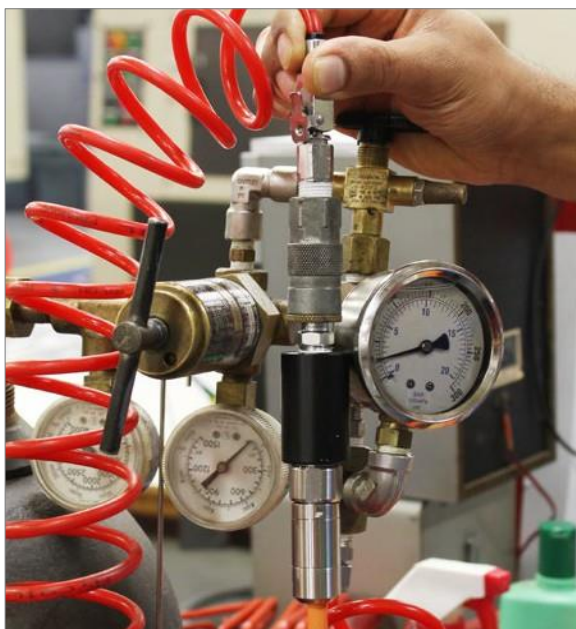
Figura 9-6 Gás Nitrogênio sendo inserido no Cabo Ventilado
